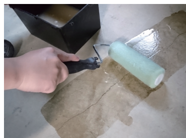
ローラー、ハケによる施工
