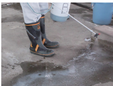
噴霧器による施工
