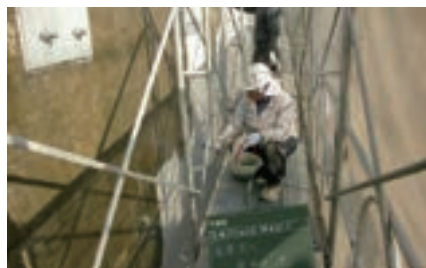
ひび割れ注入工（含浸注入）
