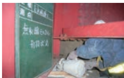
支承補修工（無収縮モルタル）
