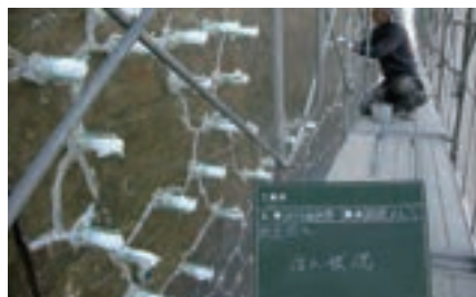
ひび割れ注入工（低圧注入）
