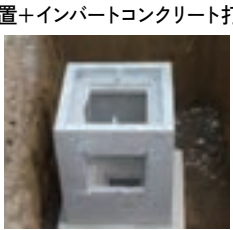
枳設置+インバートコンクリート打設
