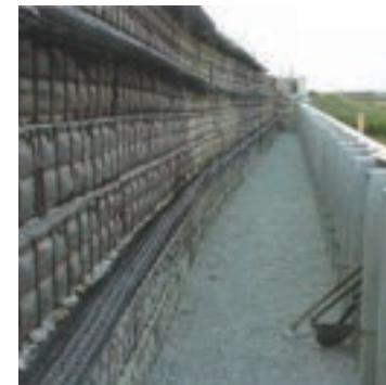
最大沈下量60cmの超軟弱地盤上に建設(福岡県国道工事)
