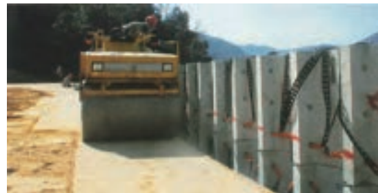
重機による壁面近傍転圧状況
