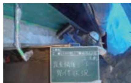
床版下面補強（CFRP）
