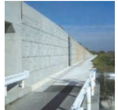
最大沈下量60cmの超軟弱地盤上に建設(福岡県国道工事)
