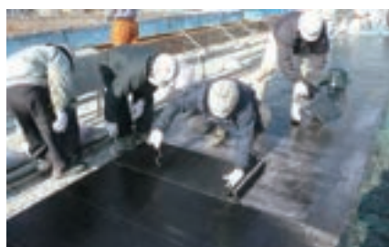
床版上面補強（CFRP）
