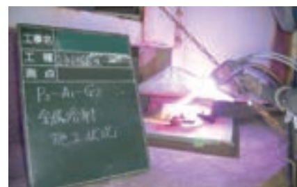
支承補修工（金属溶射）
