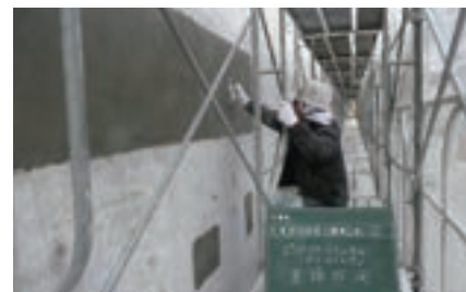
断面修復工（ポリマーセメントモルタル）
