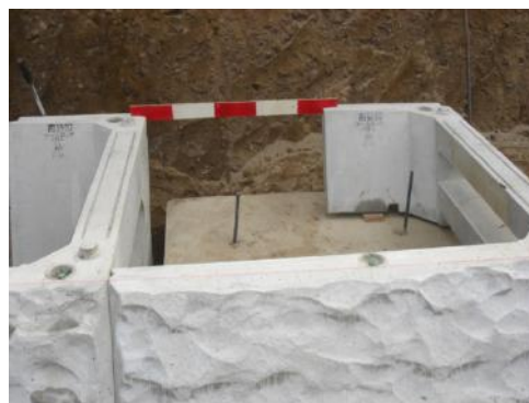
ブロック背面の間隔を測定し「通り」を確認する
