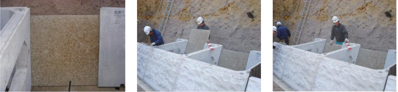
“バックアップボード”は、アームロック専用加工した“信州リサイクル製品”を使用しています。
