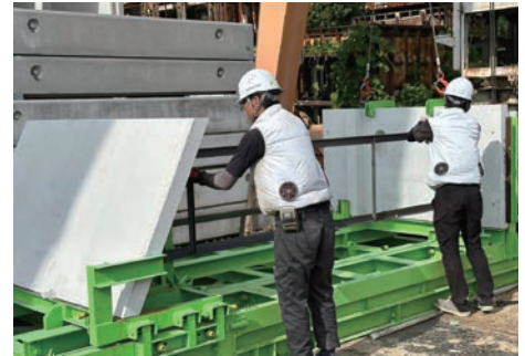
▲ ブロック組立の様子（小布施工場内）
