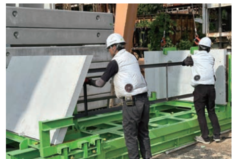
▲ ブロック組立の様子（小布施工場内）
