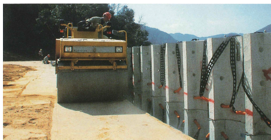
重機による壁面近傍転圧状況
