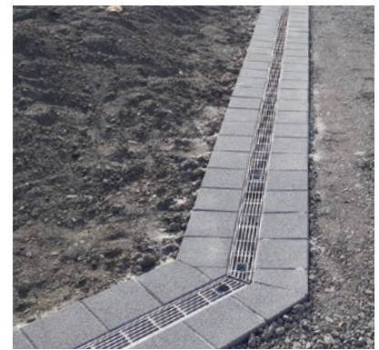
▲ インターロッキング設置例
