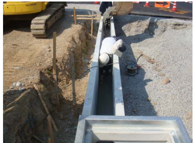
インバートコンクリート仕上げ状況
