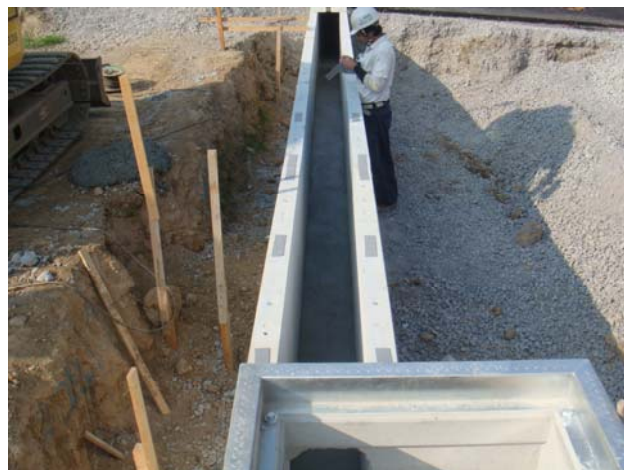
パッキン材貼付状況
