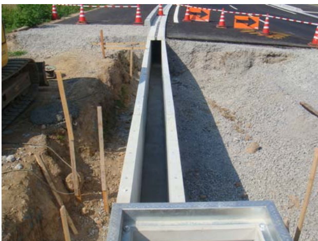
インバートコンクリート仕上げ完了
