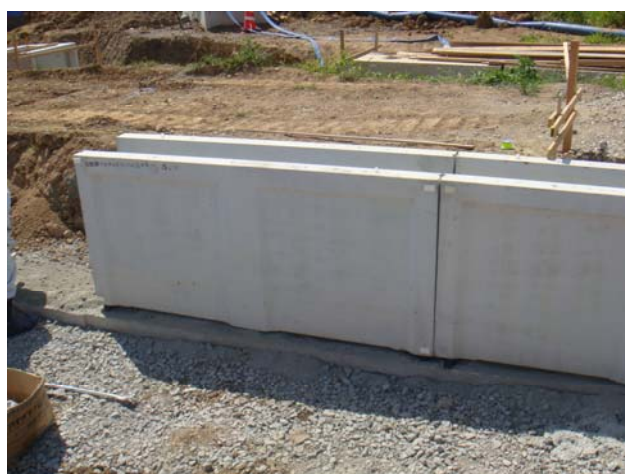
本体設置状況
