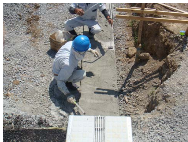
モルタル敷均し
