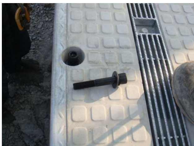
連結ボルト及び連結状況
