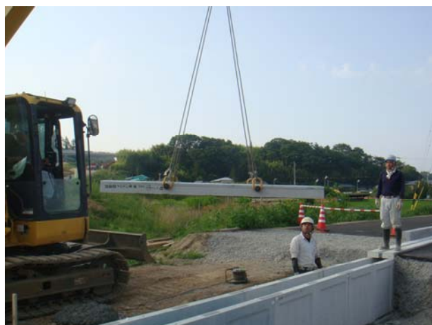
蓋版吊上げ状況
