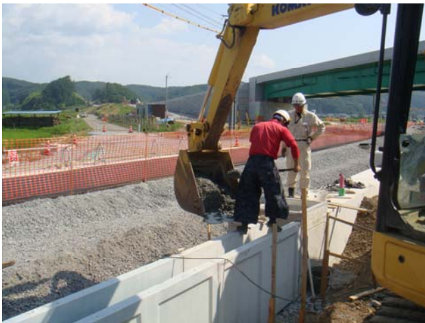
インバートコンクリート打設状況
