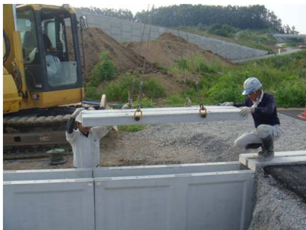
蓋版施工状況
