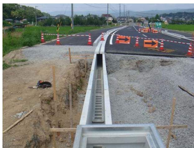
本体設置完了
