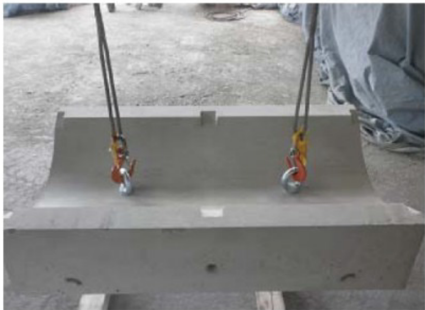
①側溝及び基礎据え付け
