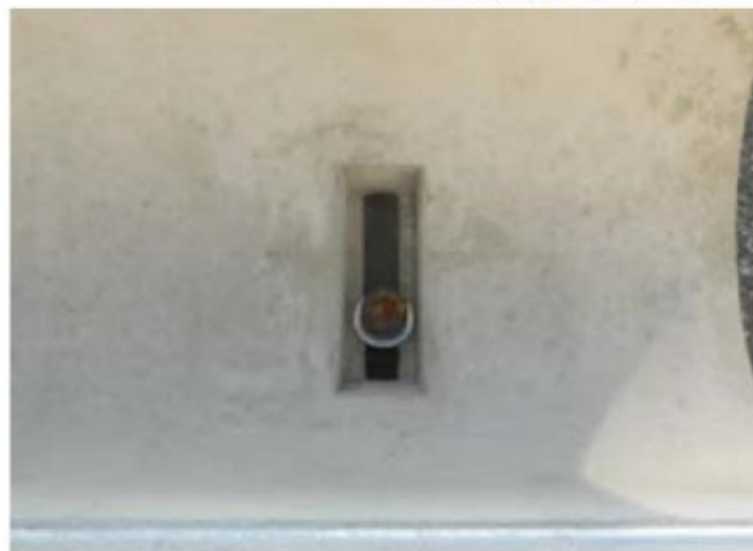
③側溝と基礎の固定、間詰モルタル施工
