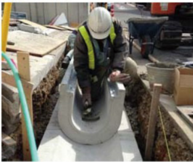
③側溝と基礎の固定、間詰モルタル施工
