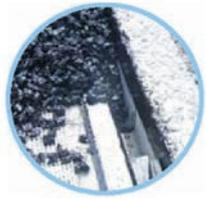
※側溝掛りとレインスルーの隙間にアスファルト合材等を充填することで、ガタツキを抑えます。
