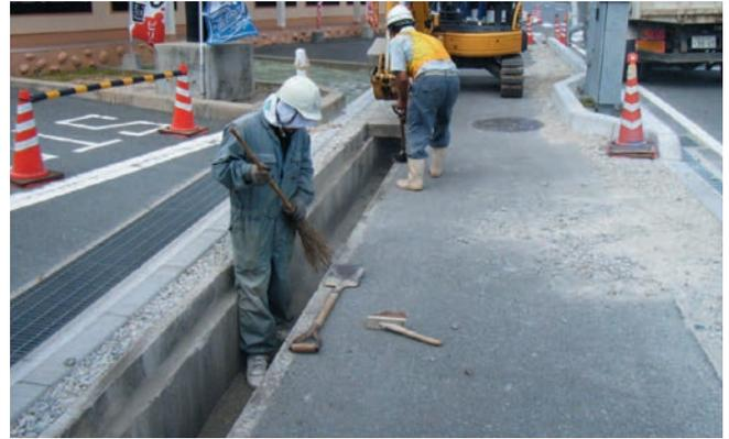
2. 製品敷設 側溝にレインスルー(C)を敷設し、その上に繊維ネット(D)をかぶせます。
