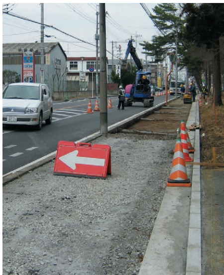
▲KCフォーム施工
