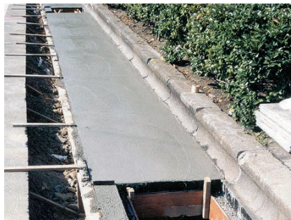
2. コンクリート打設
