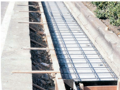
1. KCフォームの上に配筋した状態
