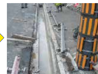
⑦レール取り外し・切断部撤去
