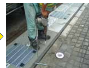
⑪アンカー筋削孔・固定
