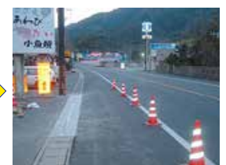
⑫施工完了
