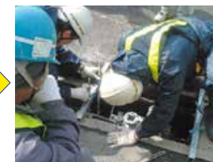
③専用治具によるレールセット
