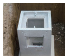
柵設置+インパットコンクリート打設
