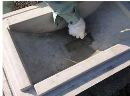
固定ボルトを設置後、付属の早強系プレミックスドモルタルにて間詰します。
