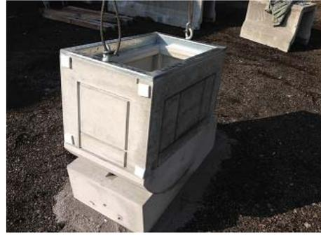
ベースを据え付け、その上に中間用ベースを設置後、バール等の工具を用いて勾配を調整します。
