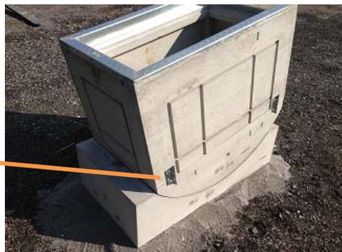
固定したベースの上に柵を設置し、側面4箇所をプレートで固定します。
