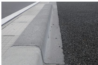
施工から2年経過
