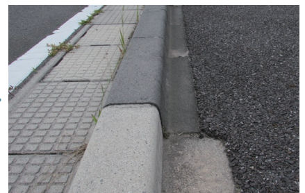
施工から6年経過
