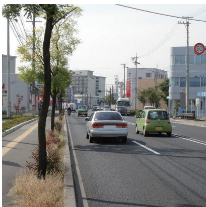
長野市(国道18号)
