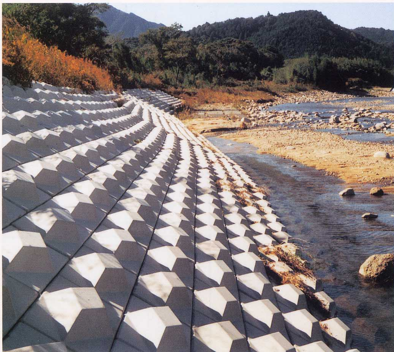
三重県 鈴鹿川底護岸補修工事
