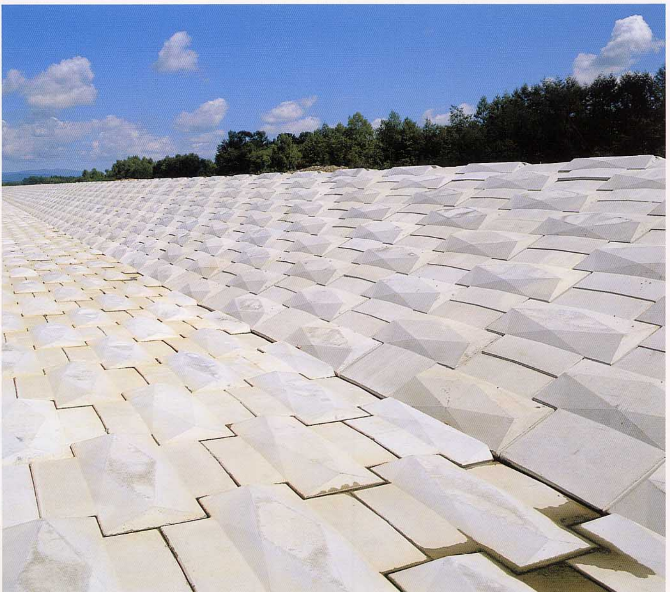
北海道 音更川改修工事
