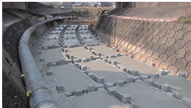
胴込めコンクリート打設
