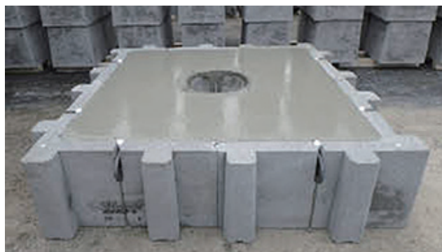
胴込めコンクリート打設
