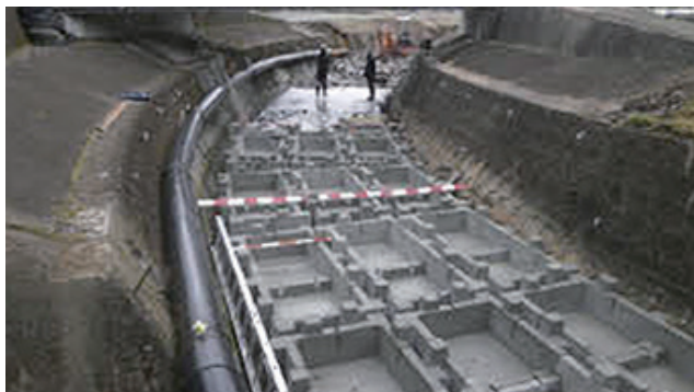
■ 2t標準施工 施工中
