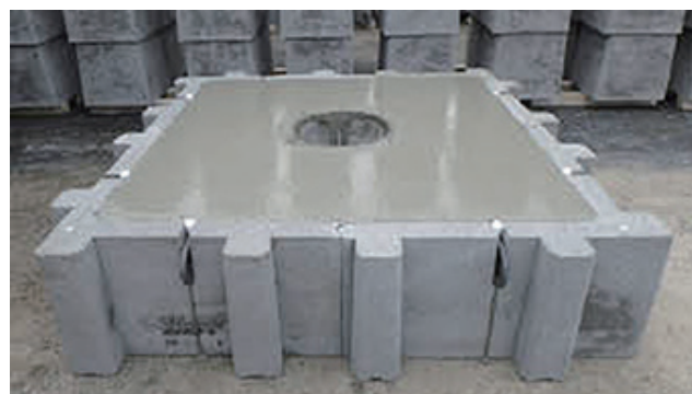
胴込めコンクリート打設
