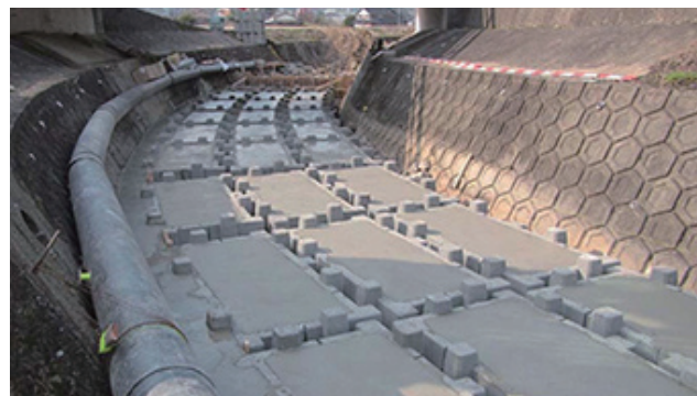
胴込めコンクリート打設
