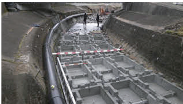
■ 2t標準施工 施工中
