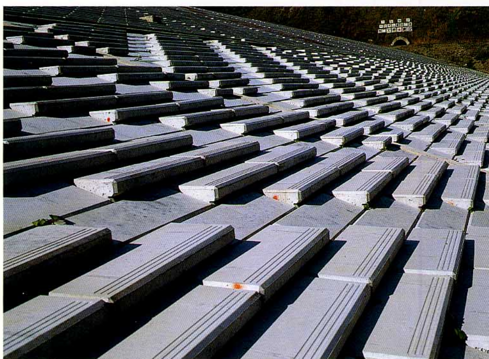
北海道三石地区三石ダム建設工事
