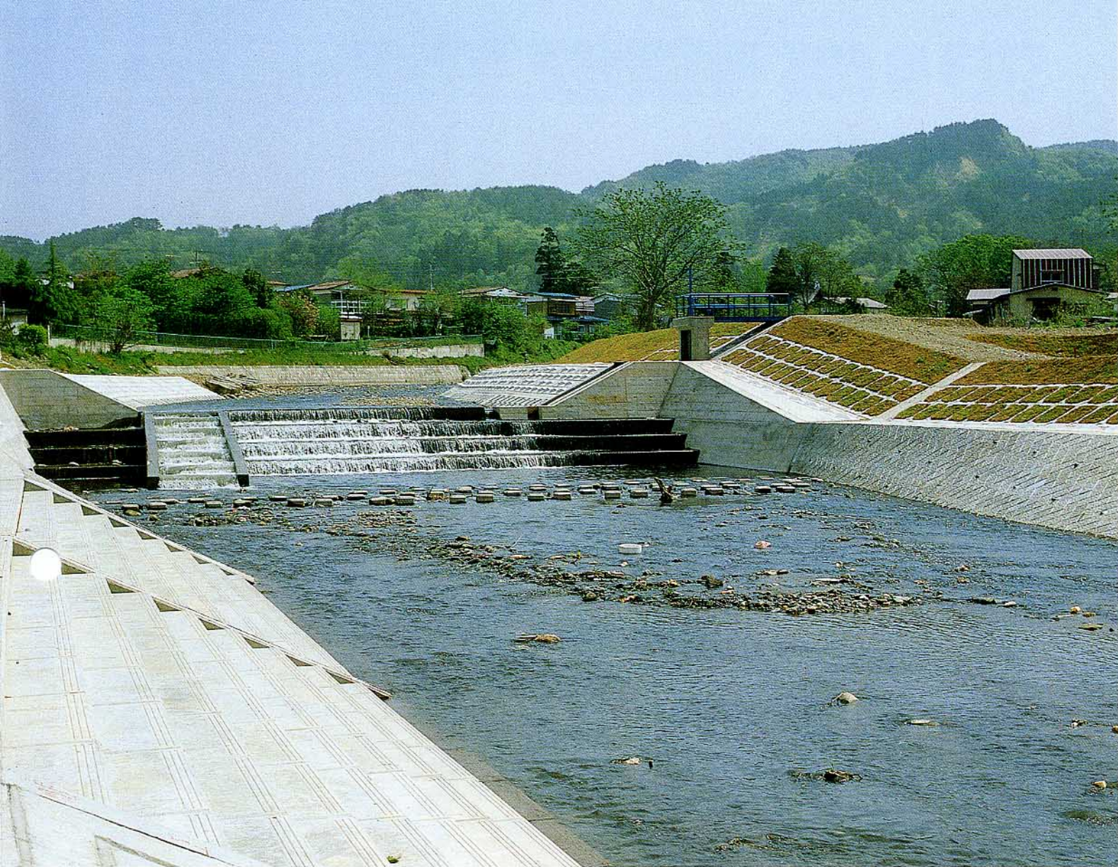
福島県湯川中小河川改良工事
