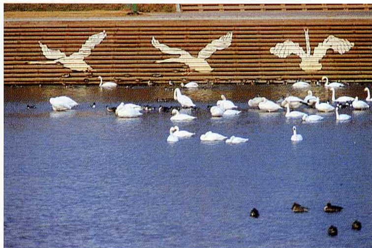
宮城県 迫川河川改修工事
