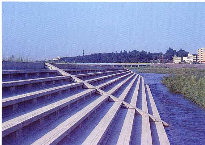
栃木県 思川中小河川改修工事
