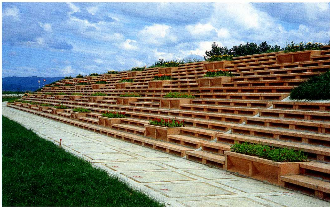
北海道天塩川河川改修工事
