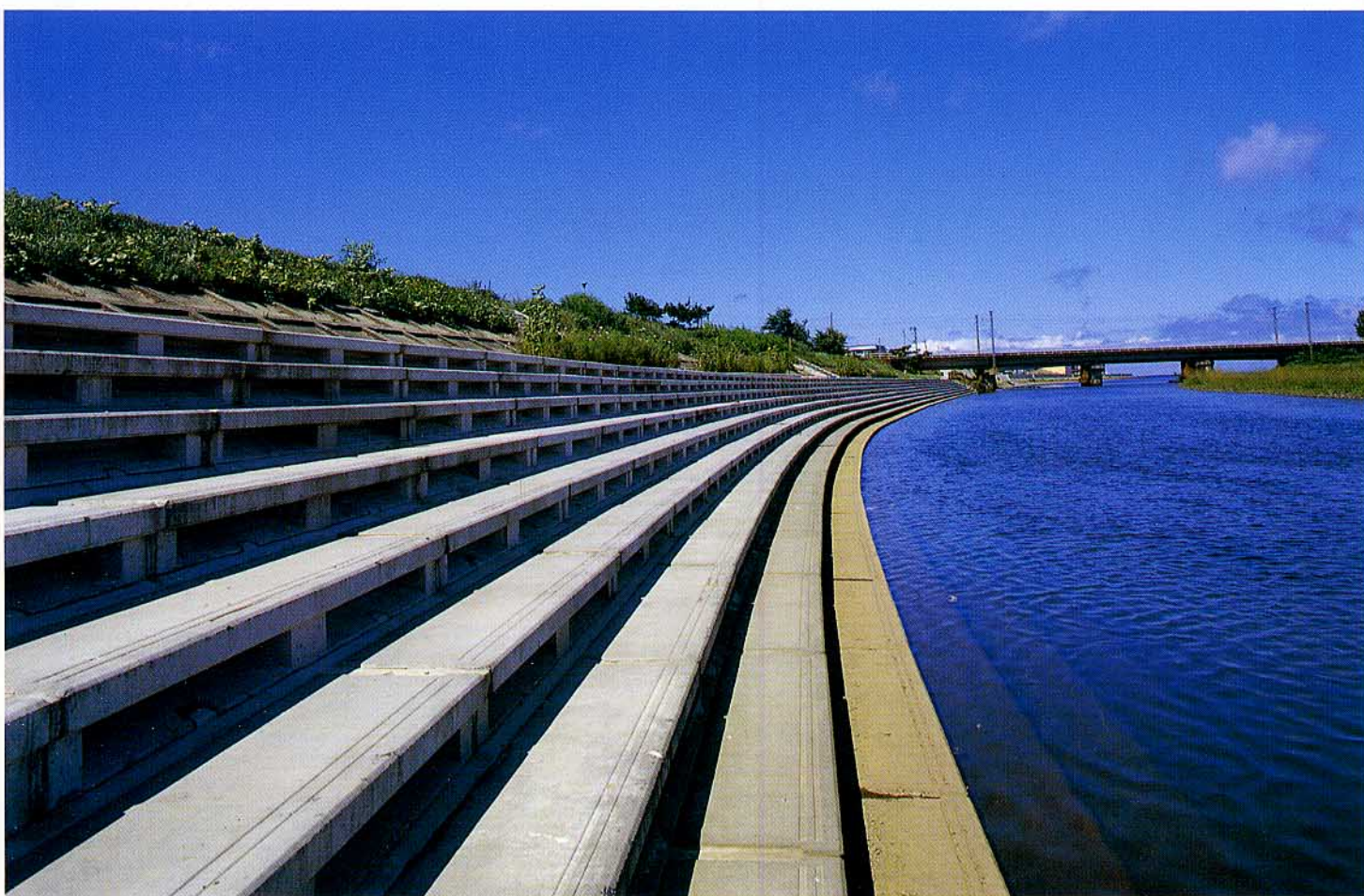
青森県 野内川河川災害復旧工事
