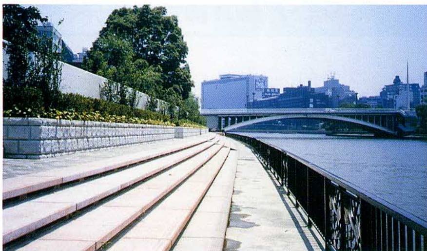
大阪府 堂島川河川改修工事
