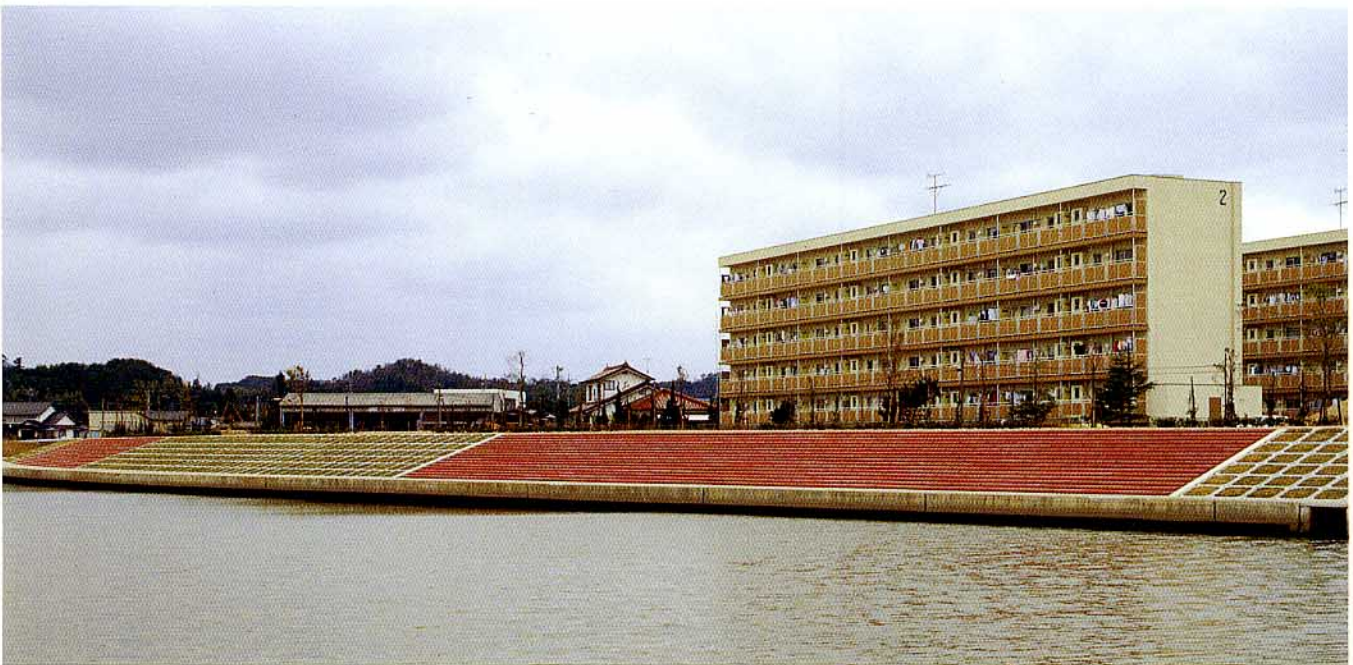
島根県舟川河川改修工事
