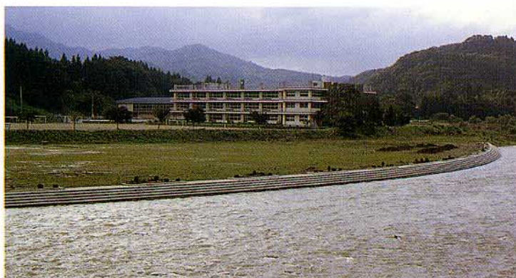
福島県 久慈川河川改良工事
