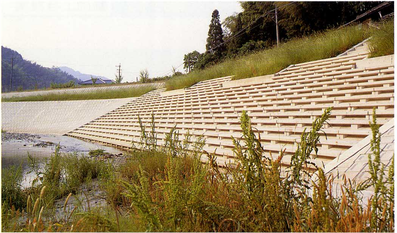
福岡県 白木川災害復旧助成工事
