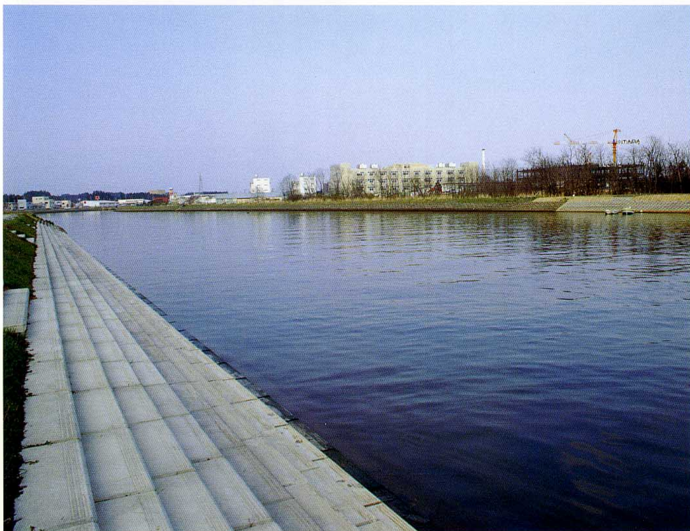
青森県田名部川中小河川改修工事
