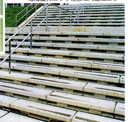
北海道共栄中学校敷地内造成工事
