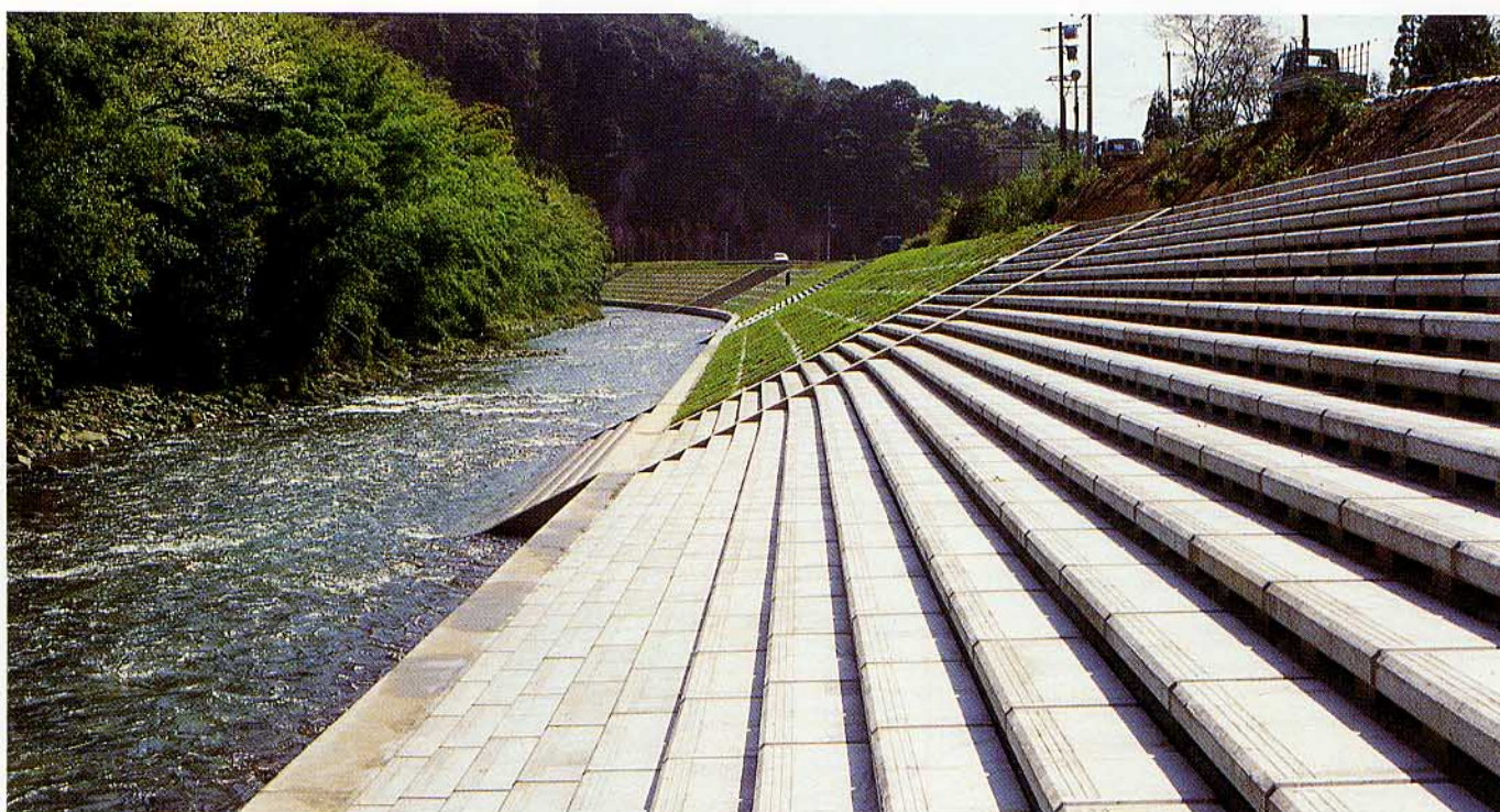
鹿児島県万之瀬川護岸改修工事
