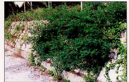
施工後1年6ヶ月
