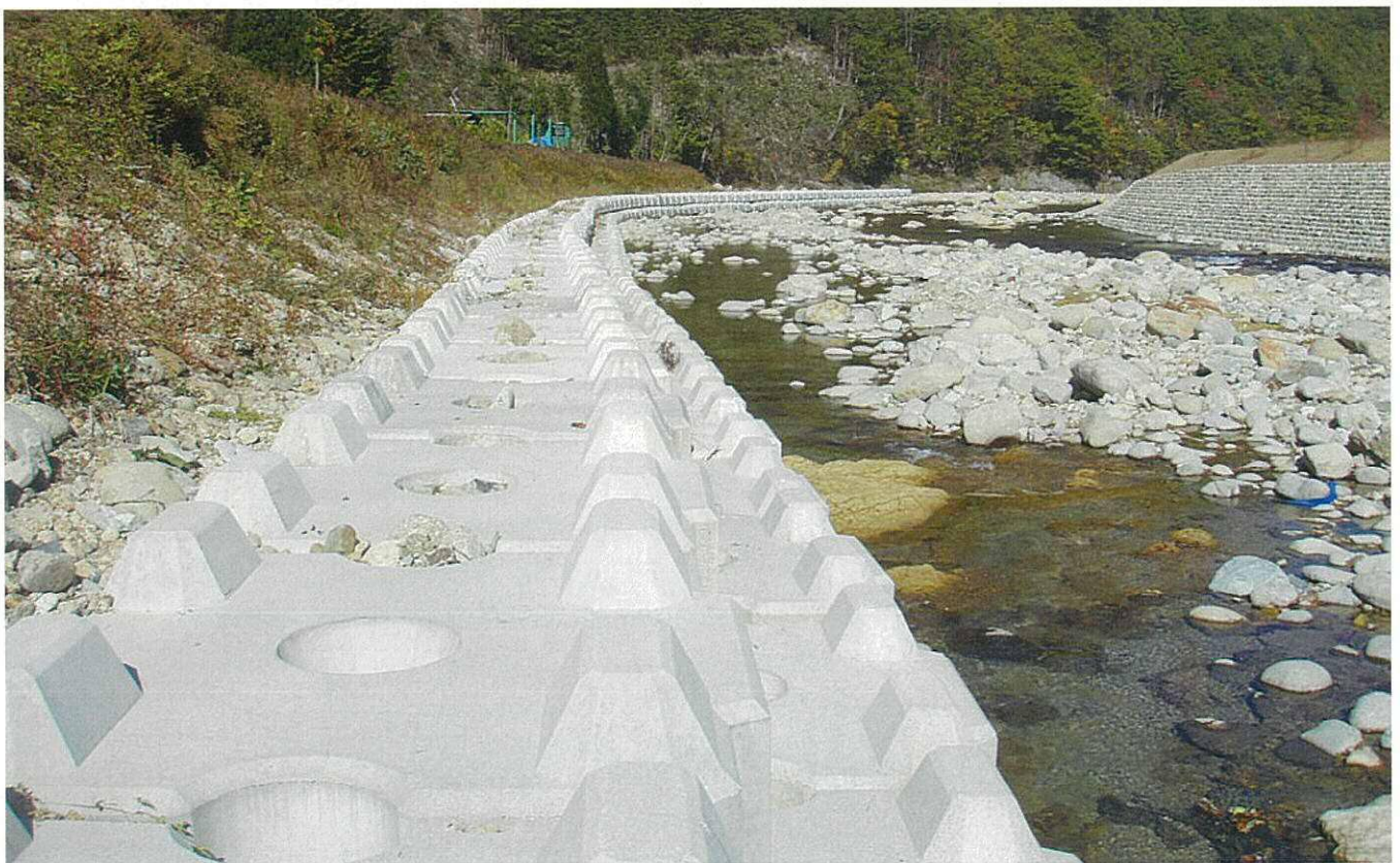
岐阜県 川上川改修工事
