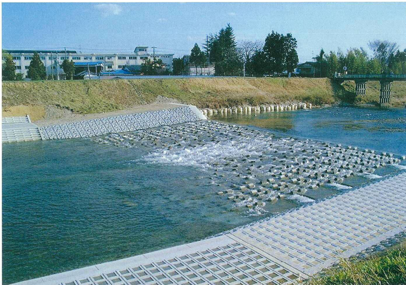
福島県 床上浸水対策特別緊急事業（宇多川筋）
