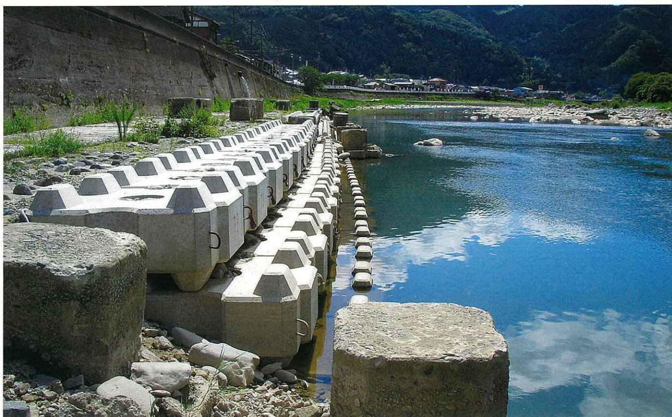
岐阜県 公共広域基幹河川改修事業 飛騨川
