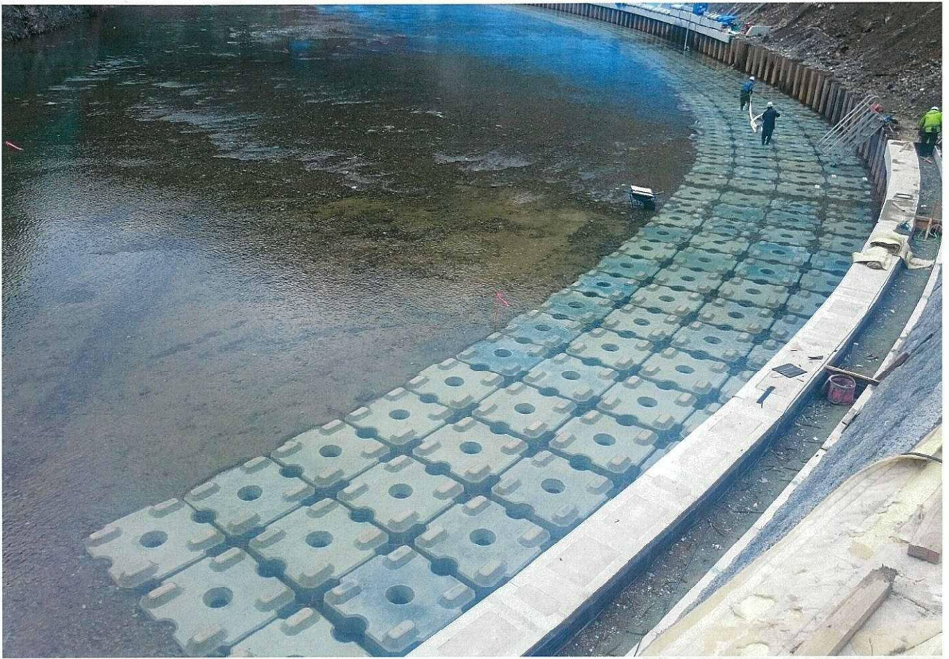
紀伊山系砂防事務所 坪内地区護岸設置他工事
