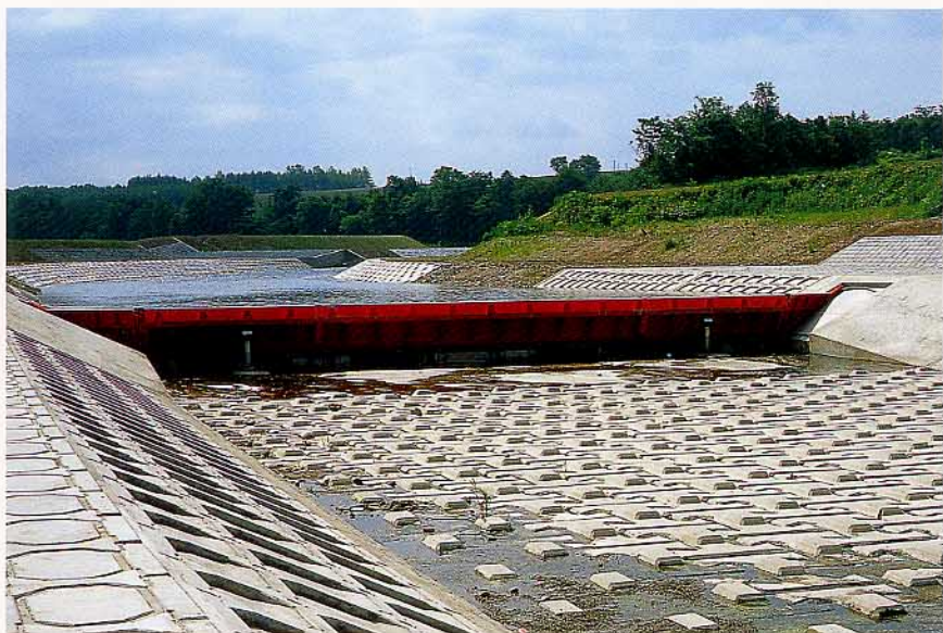
北海道宇莫別川災害復旧工事
