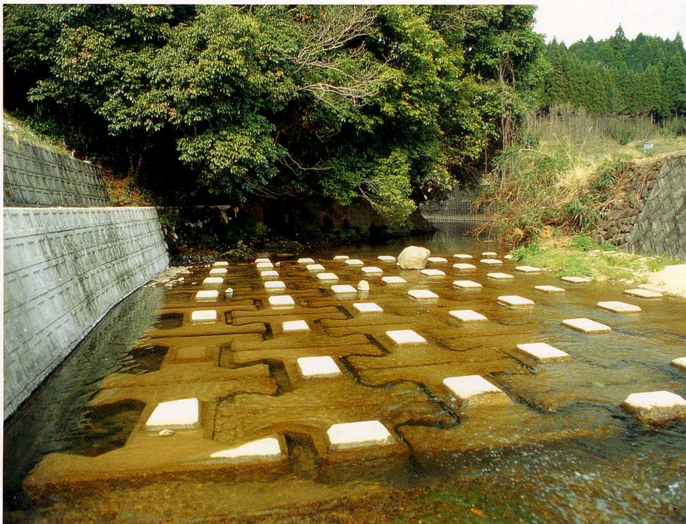
熊本県永野川河川工作物工事
