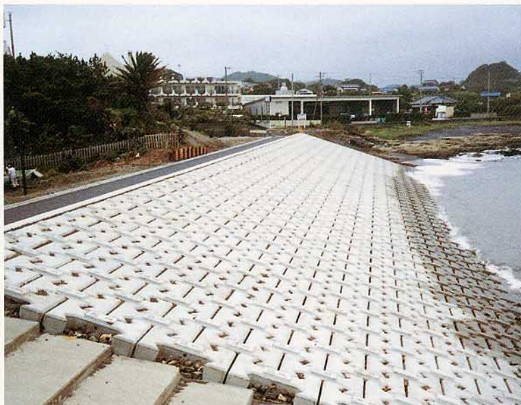
千葉県千倉海岸災害復旧工事
