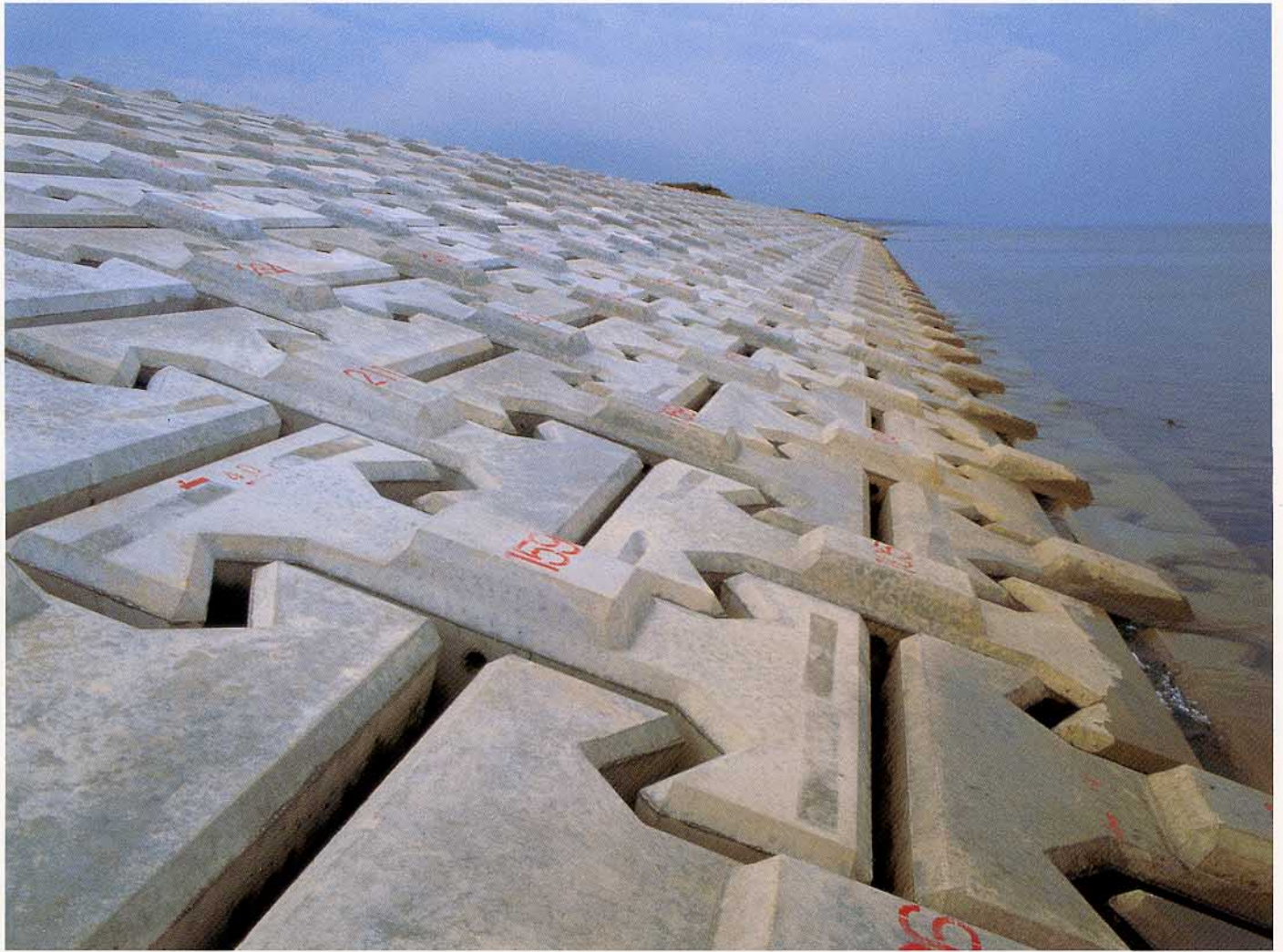
青森県雲雀平海岸災害復旧工事
