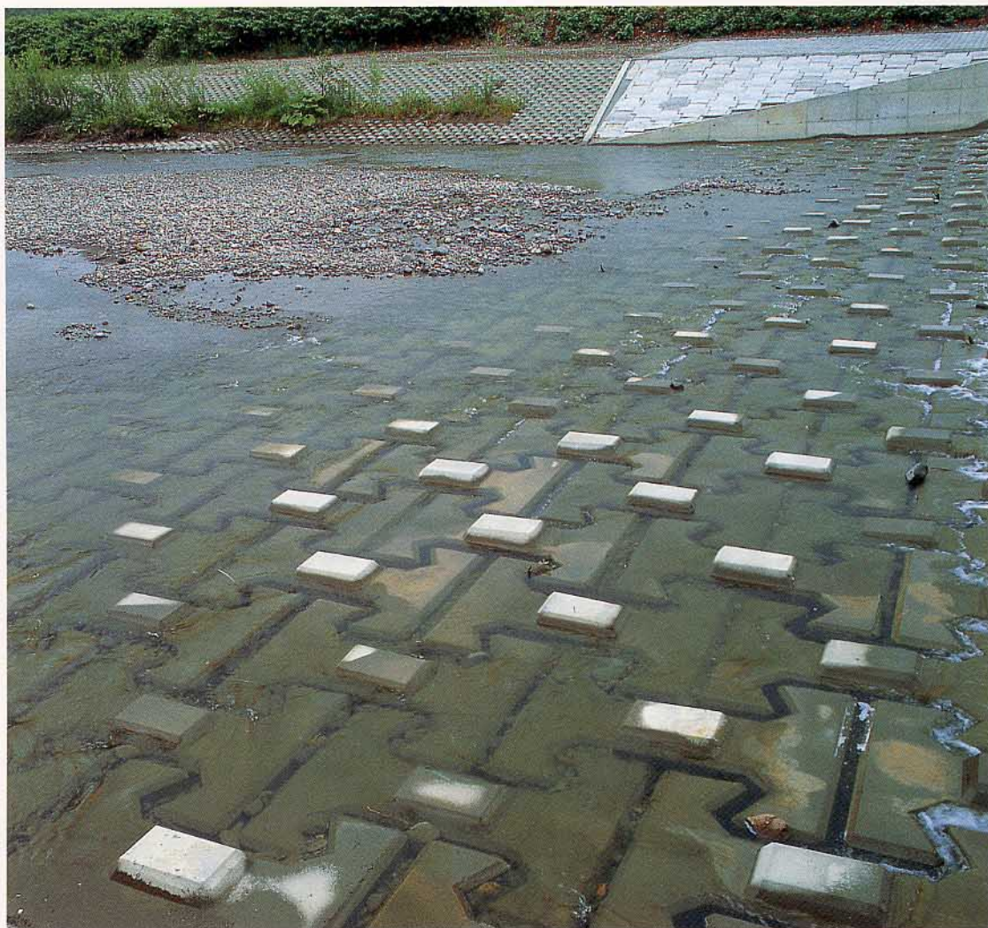
北海道横内頭首工工事
