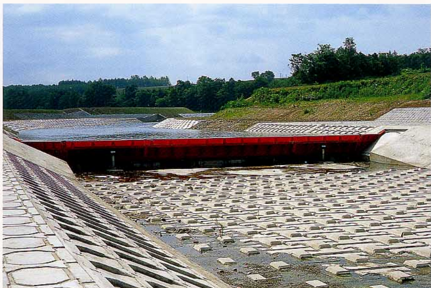
北海道宇莫別川災害復旧工事
