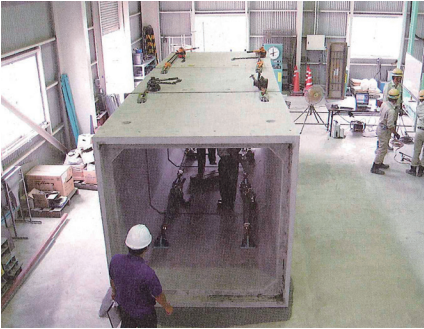
曲線施工試験 (IB50 タイプ)
