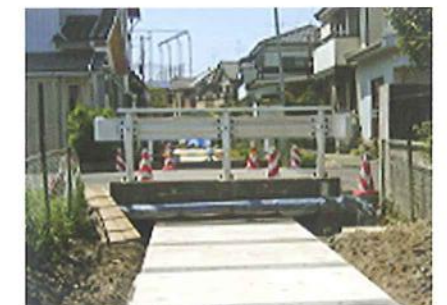
▲既設橋梁下横断
