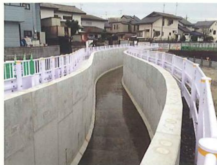
▲施工後（急曲線部 R=20m、30m）
