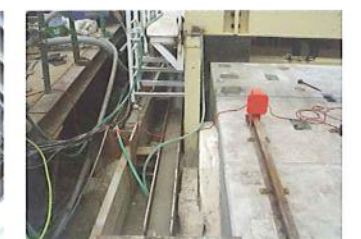
▲裏込注入状況
