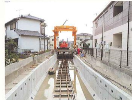
▲施工中(敷設済みU型開渠)
