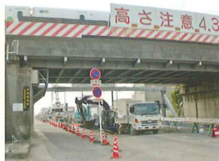
▲施工全景(JR高架下施工状況)
