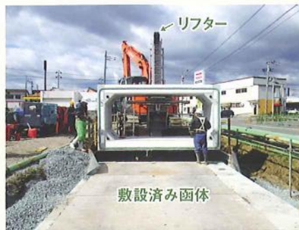
▲函体敷設状況
