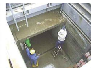
▲函体縦締用PC鋼棒緊結状況
