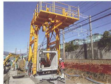
▲施工状況(函体据付)
