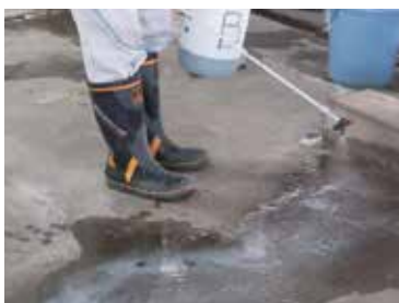
噴霧器による施工
