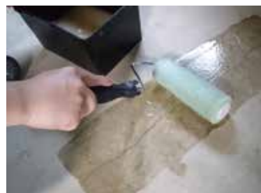
ローラー、ハケによる施工
