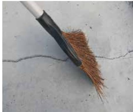
Vカット処理で出た粉塵はMR3と下地の付着を阻害するため、ホウキ等で清掃します。
