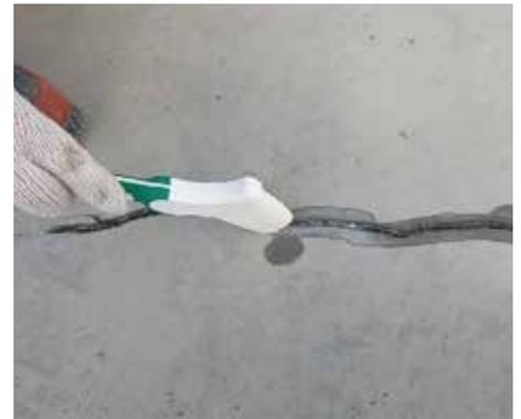
下地との付着を十分にするために、浸透性のプライマーを塗布します。
