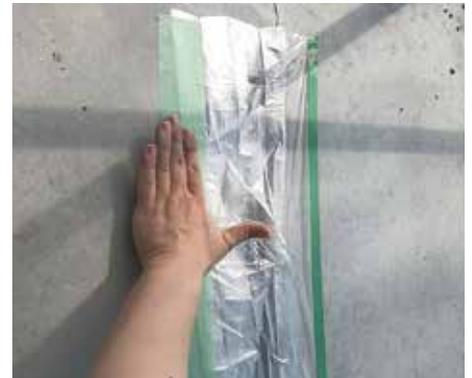
施工した後、乾燥や風雨を防ぐため、シート等を用いて養生を行います。
