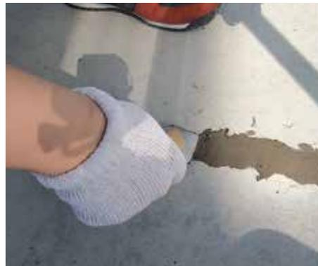
コテ圧をかけながら下地に密着するように施工します。1層あたりの塗厚は約5mm程度とし、その後所定の厚さまで塗り重ねます。
