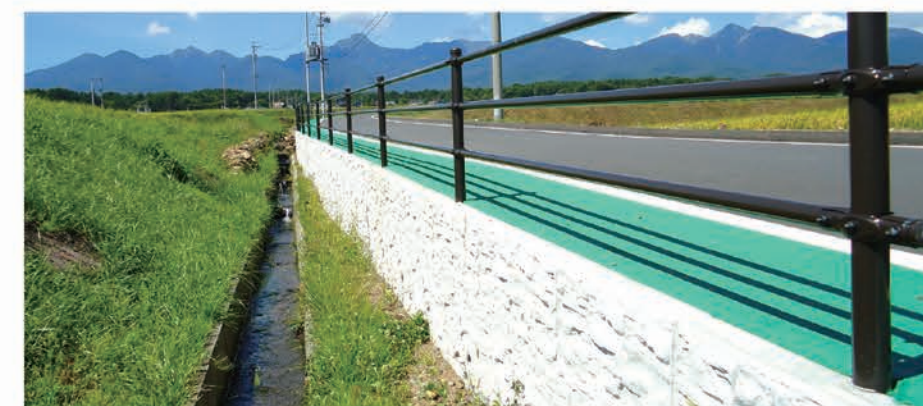
※写真：L型擁壁H1000
